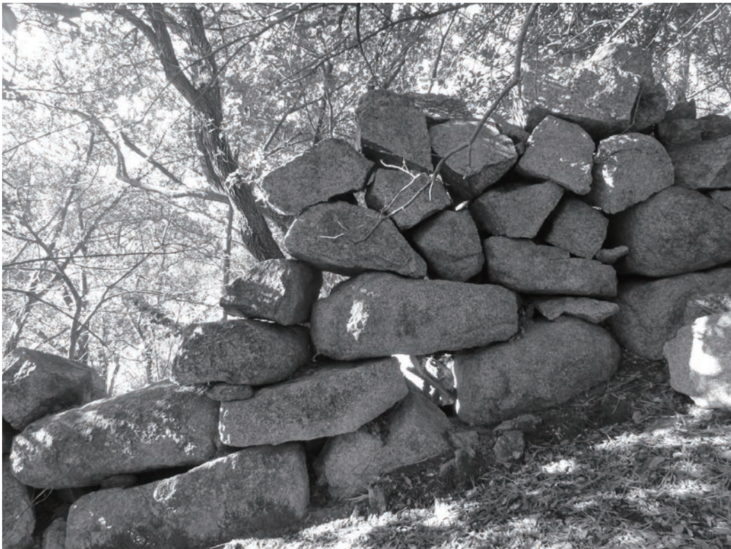
写真：小海・鉾(ちょうな)石付近。昇龍のように急斜面を駆け上る。積み石は横に寝かせ、重力が均等にかかるように重ね継ぐ。花崗岩質の野面石や割石を使った地場の築石技術。
